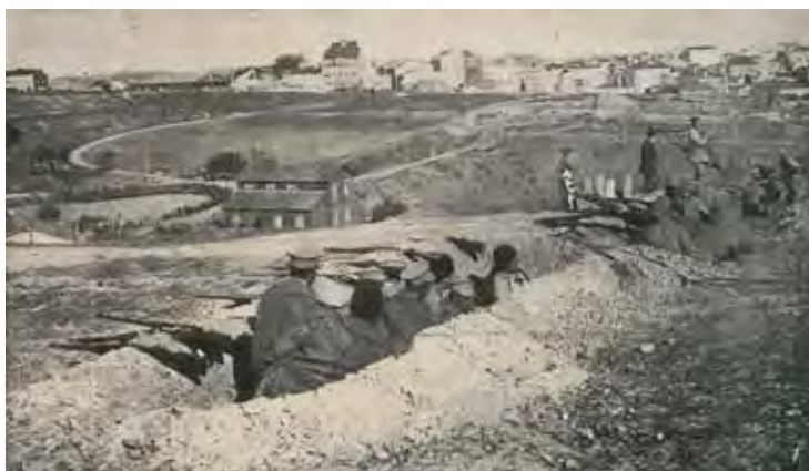
Fig.7 e 8 – Artilharia e Infantaria instaladas no terreno. Autor: Fotografia não identificado - Revista Ilustração Portuguesa, n.º 617 - 1917
