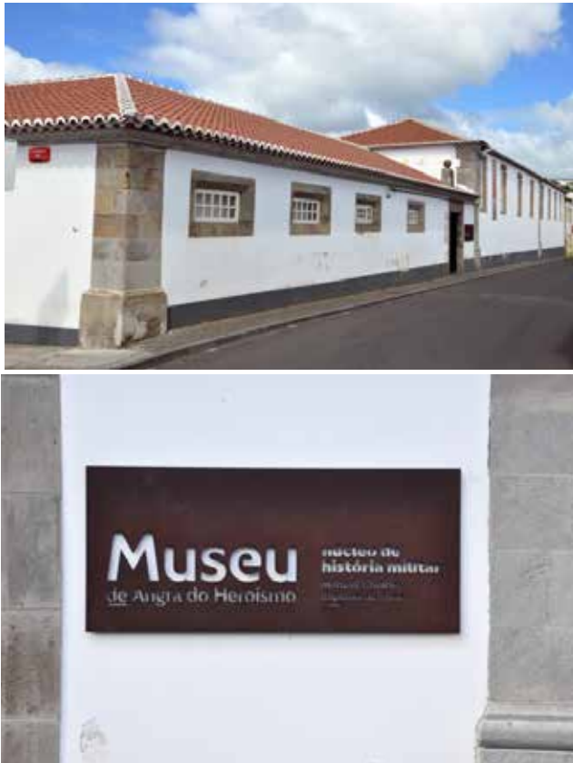
Fig. 1 e 1a - Núcleo de História Militar Manuel Coelho Baptista de Lima, antigo Hospital da Boa Nova. Vista da fachada norte, com a entrada principal.
